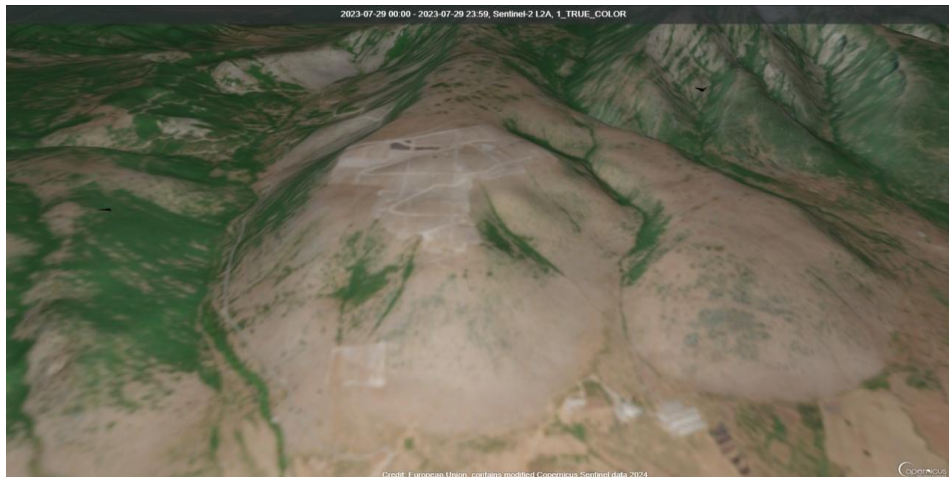
Το χαρτογραφικό αποτύπωμα του υψώματος Πανοράματος όπως καταγράφεται τον Ιούλιο του 2023 από τον δορυφόρο της Esa sentinel – 2 (έναρξη εργασιών)
